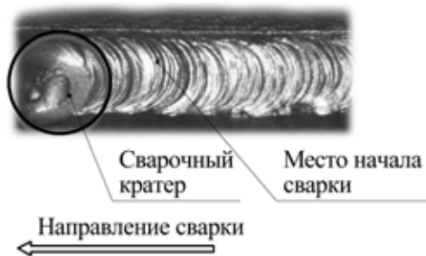
Рис. 8.4. Начало сварки при смене электрода.
